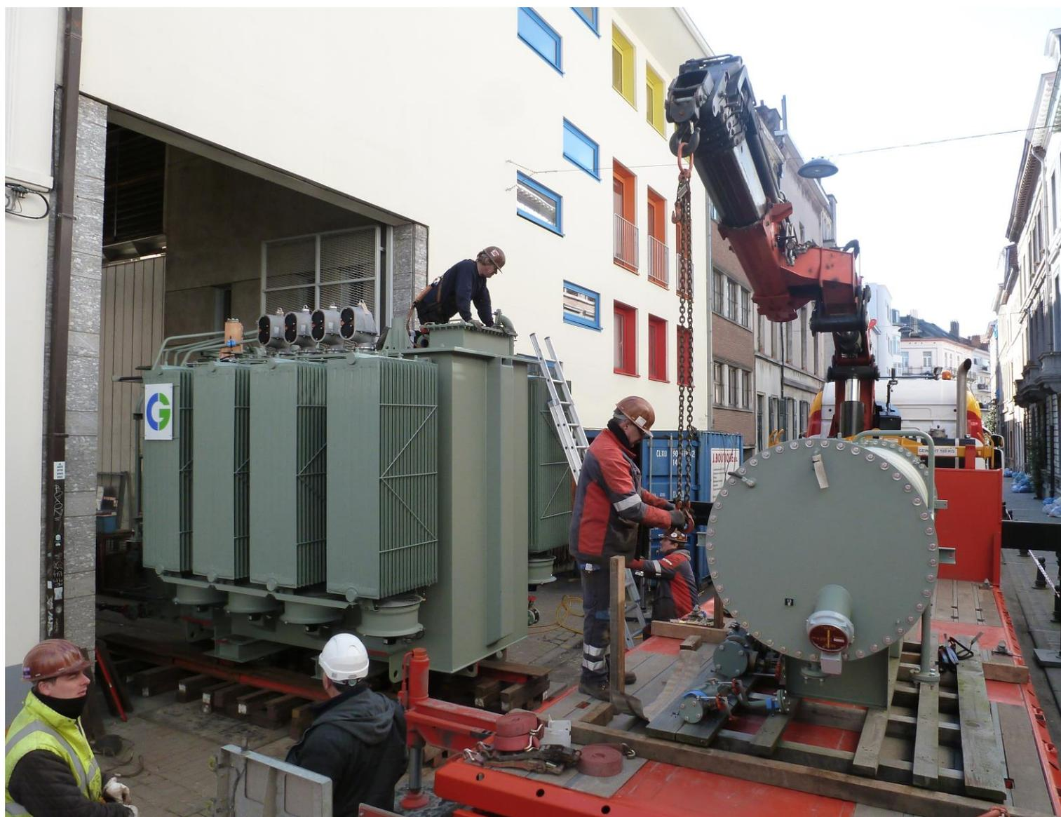
Photo de couverture : Livraison d'un transformateur 36/11-5 kV au poste de Naples
